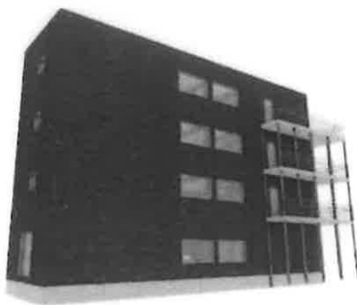
図 1-5 4 階木造ビルの試設計のパース
